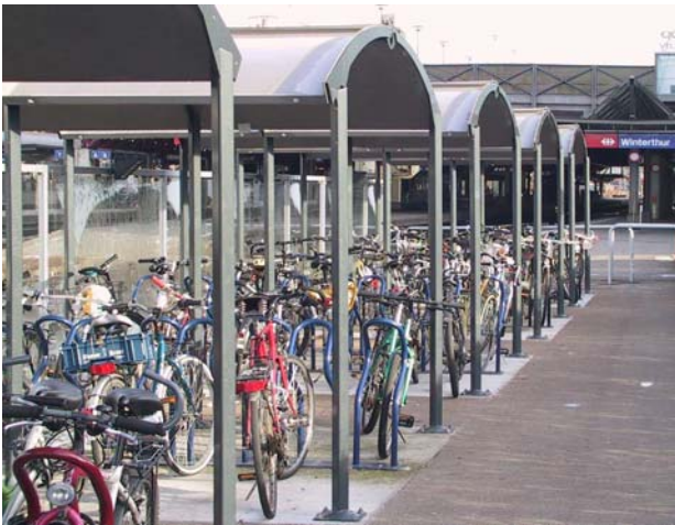
Am 11.08.2003 wurde die benutzerfreundliche Veloabstellanlage beim Hauptbahnhof Winterthur eröffnet.
